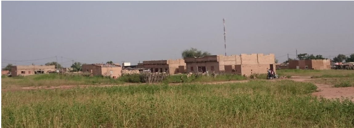
Photo 1 : extension de la ville de Ranérou.
